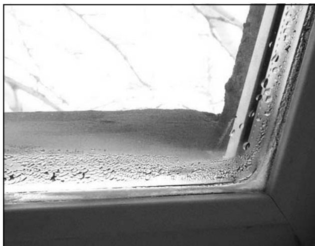
Рис. 1. Образование конденсата и наледей на поверхности стеклопакета в краевой зоне
