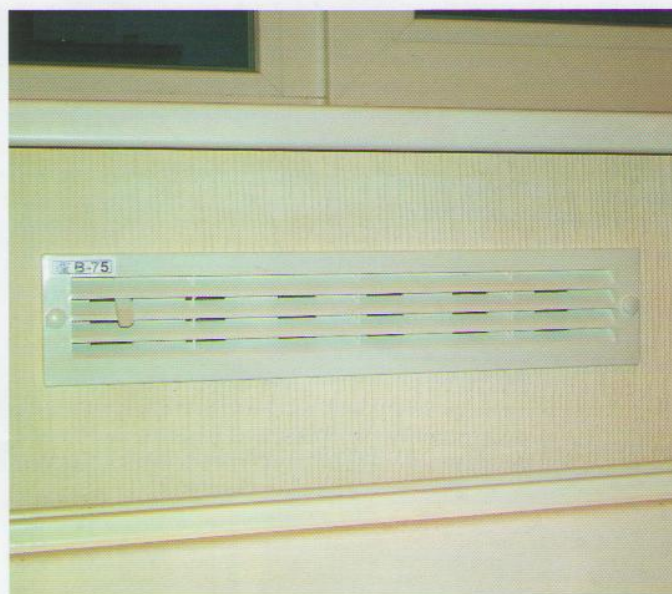
Рис. 4. Внешний вид некоторых приточных устройств: а – оконный клапан ЕММ; б – стеновой клапан КИУ; в – стеновой клапан СВК В-75
